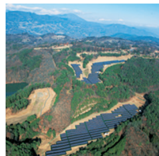
川中嶋太陽光発電所
