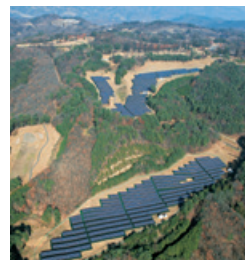
川中嶋太陽光発電所
