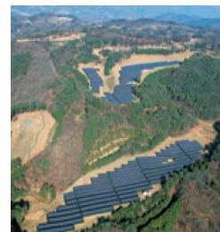
川中嶋太陽光発電所
