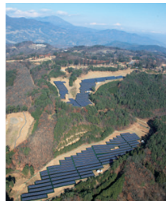
川中嶋太陽光発電所
