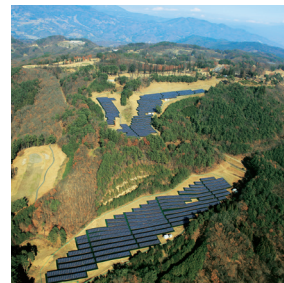
川中嶋太陽光発電所
