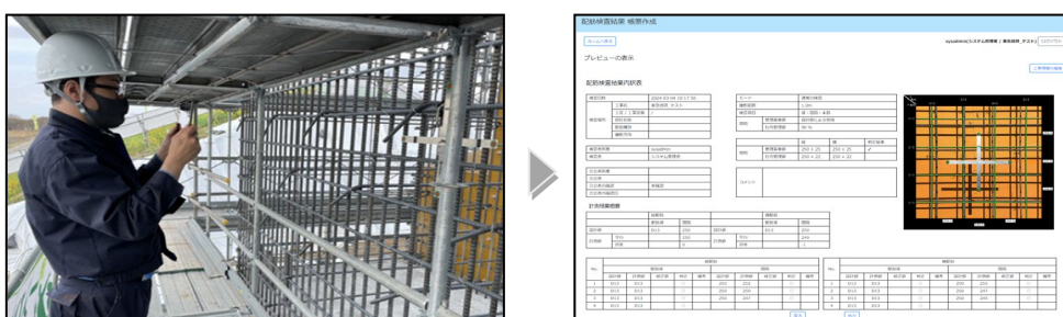
図2 配筋自動検査状況および帳票出力例
