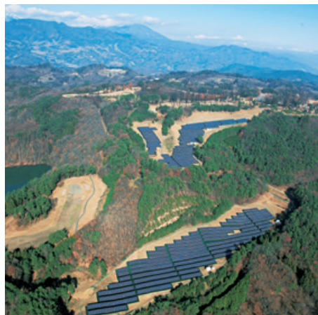
川中嶋太陽光発電所
