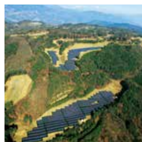
川中嶋太陽光発電所
