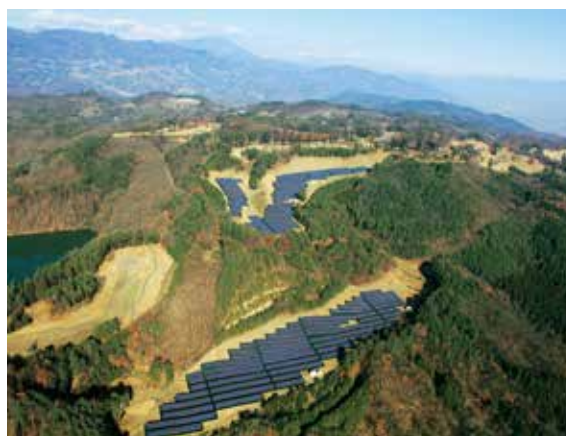
川中嶋太陽光発電所
