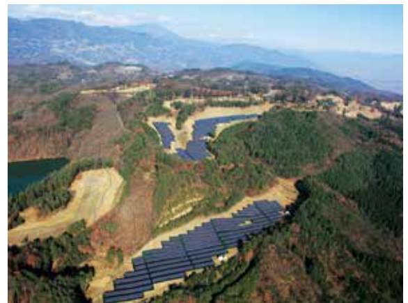
川中嶋太陽光発電所
