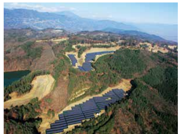
川中嶋太陽光発電所
